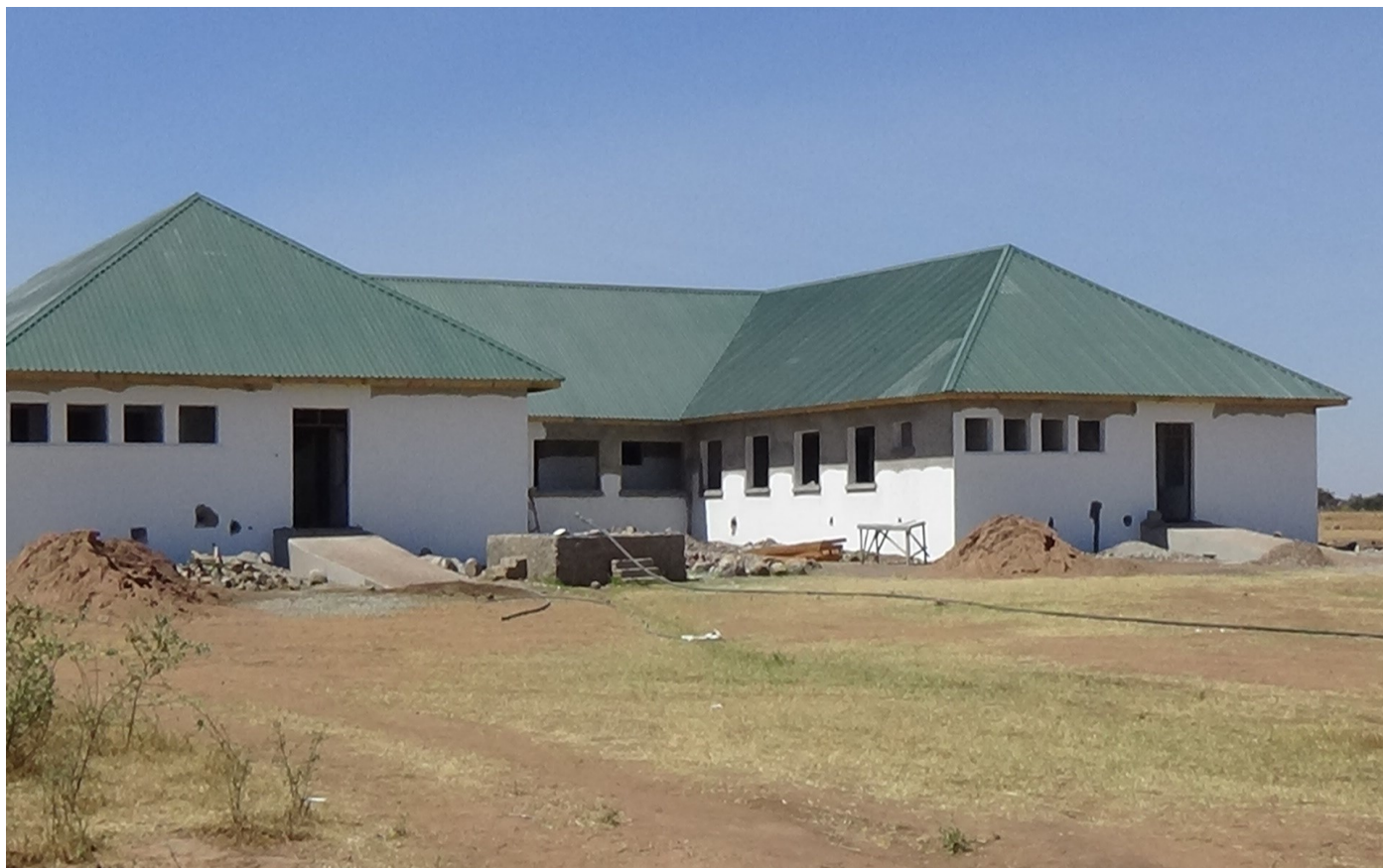
Jengo La Wodi ya Wazazi(Maternity Ward) la Hospitali ya Wilaya ya Itilima Likiwa katika Hatua ya Ukamilishaji.
