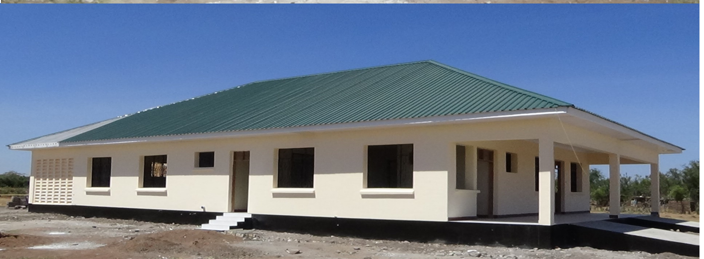
Jengo La Ufuaji (Laundry) la Hospitali ya Wilaya ya Itilima
