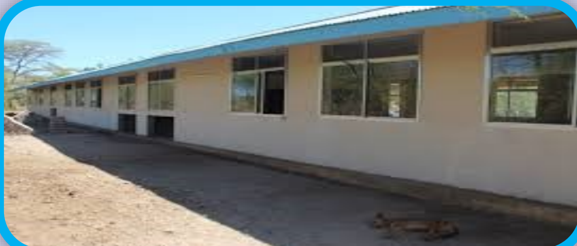
Muonekano wa nje na ndani wa Maabara ya Kisasa ya Shule ya Sekondari Budalabujiga
