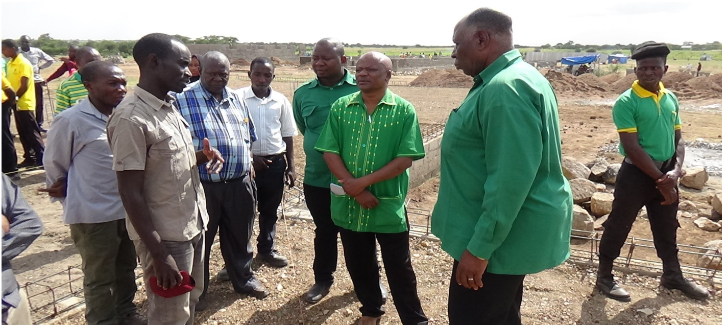
Mwenyekiti wa Kamati ya Siasa Mhe. Mzee Enock Yakobo akimsikiriza Fundi Kiongozi wa ujenzi wa Jengo la wodi ya Wazazi katika eneo la ujenzi wa Hospital ya Wilaya ya Itilima.
