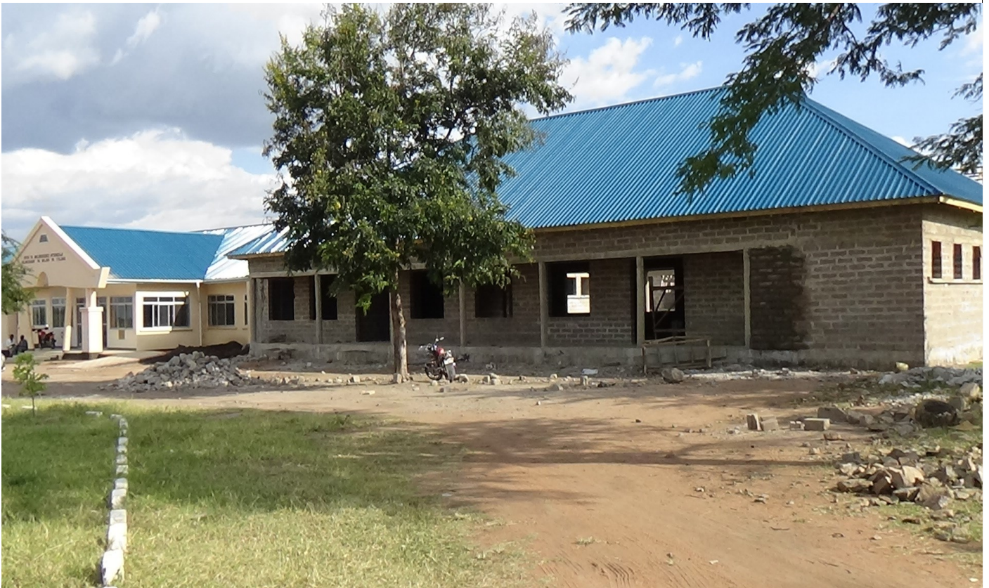
Jengo la ofisi ya Mkurugenzi wa Halmshauri ya Wilaya ya Itilima (ujenzi wa awamu ya pili) likiwa katika Muonekano wa kuelekea katika hatua za mwisho za ukamirifu.
