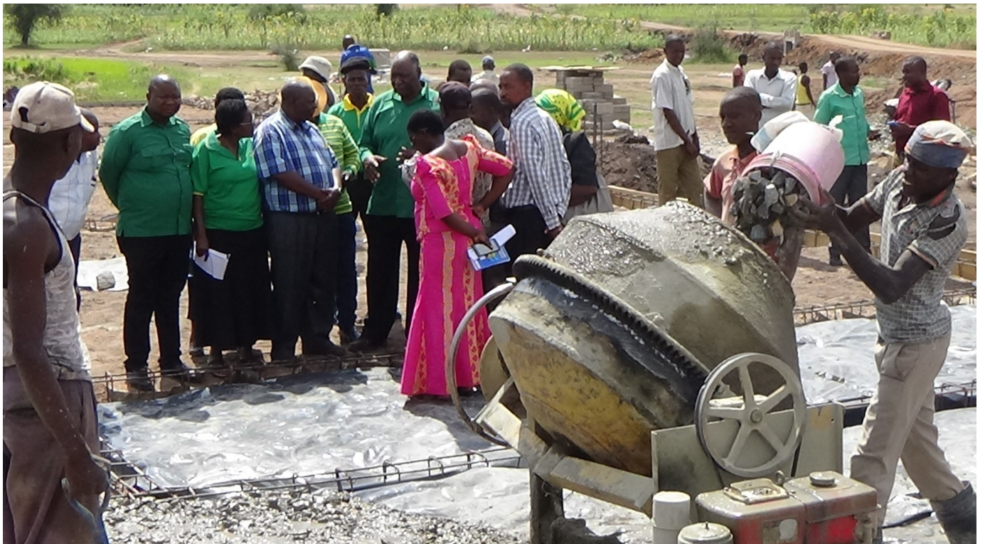
Kamati ya Siasa ya mkoa chini ya Uongozi wa Mwenyekiti wa CCM Mkoa wakishuhudia uwekaji wa Jamvi katika ujenzi wa j Jengo la Utawala la Hospitali ya wilaya ya Itilima
